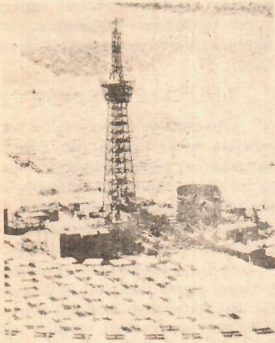
İlk güneş termik elektrik santrali inşaatı
